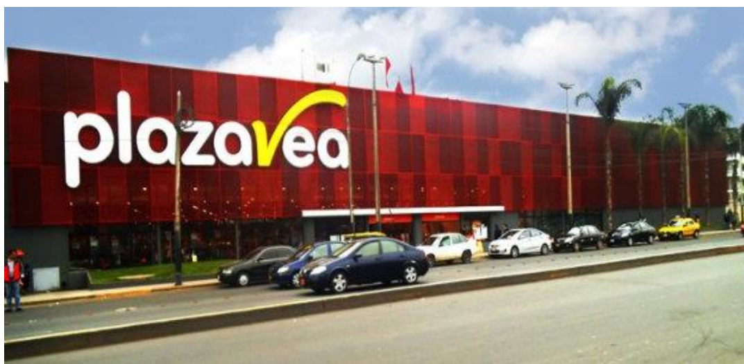
Figura 5.10 Vista actual de la construcción
