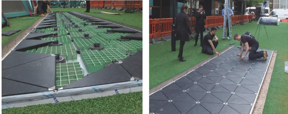
Figura 4.8. Instalación del Sistema
