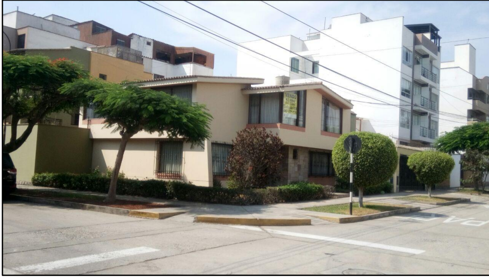
Fotografía 3.1 Inmueble ubicado en Castilla La Vieja esquina La Carabela - Surco
