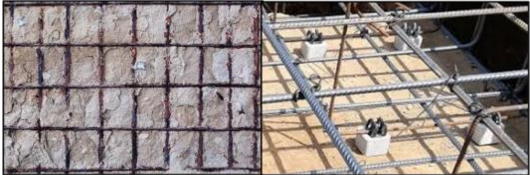
Figura 13: Comparación del uso de separadores de concreto
