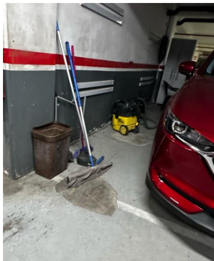
Ilustración 38: Elementos ubicados incorrectamente
